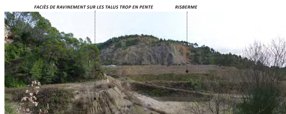
Vue 7 - Couches successives de remblais s'appuyant sur les fronts de la carrière basse
