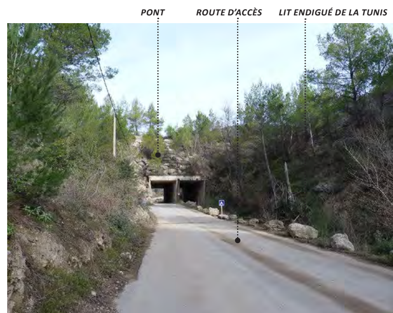
Vue 1 - Importants aménagements d'accessibilité / gestion des eaux
