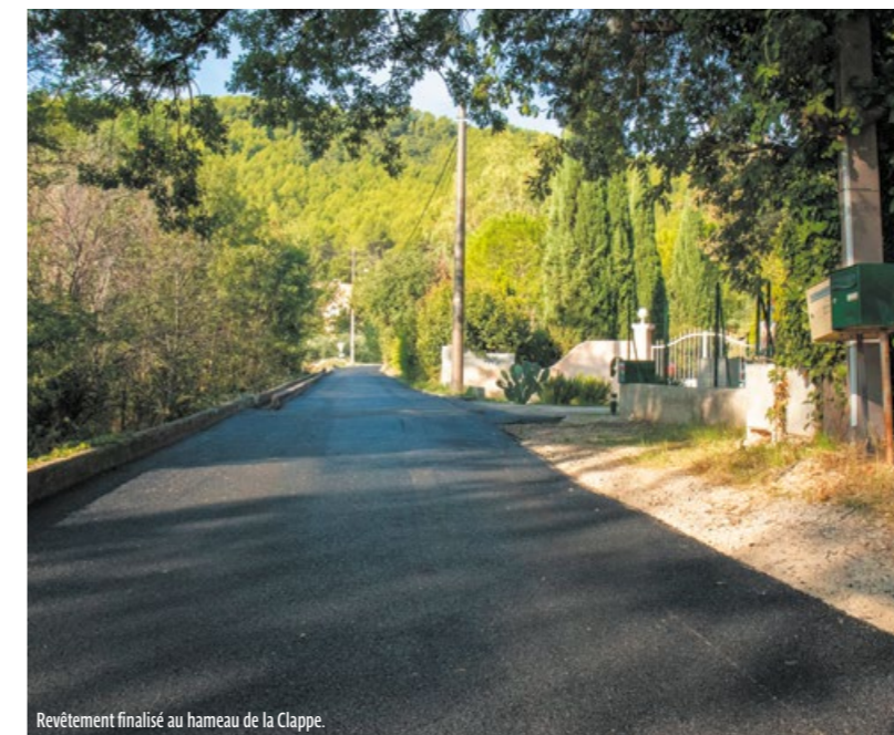
Revêtement finalisé au hameau de la Clappe.
